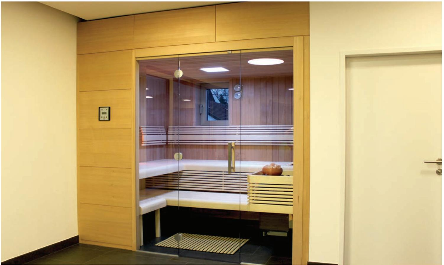
**Modell Aurora.** Eingebaut in einer Nische, komplettiert diese Sauna die Ausstattung eines privaten Fitnessraums. Das bestehende Alu-Fenster wurde mit einer Laibung in die Sauna integriert. Die Revisionsklappe oberhalb der Sauna fügt sich harmonisch ins Bild der Anschlussverkleidung.
